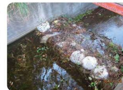
土のうによる洪水吐のかさ上げ
