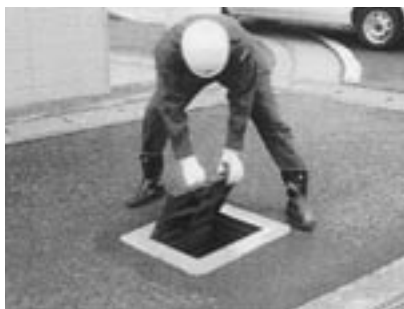
④ 消火栓の蓋を開けると。
