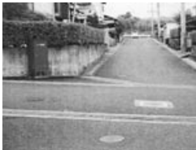
① 交差点中央にある四角いものが消火栓、左奥にある箱が消火栓ボックスです。
