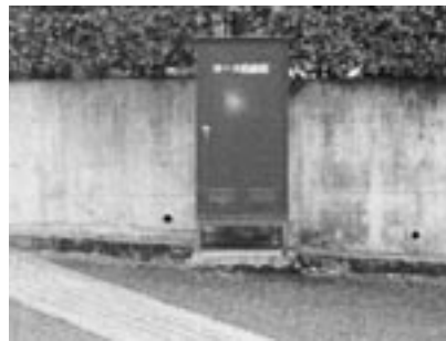
② 消火栓ボックスです。 ※ホース格納箱と表示してあります。
