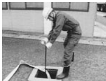
⑧ バルブを反時計回りに回すと、放水できます。（今回の訓練では、水は出さないこととします。）
