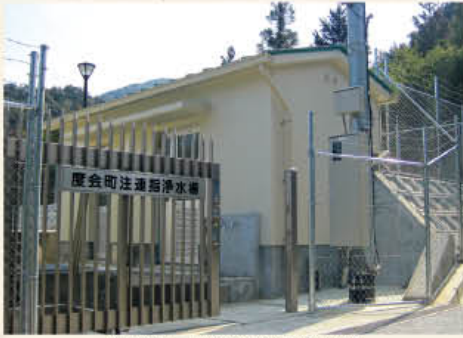
西部簡易水道注連指浄水場
