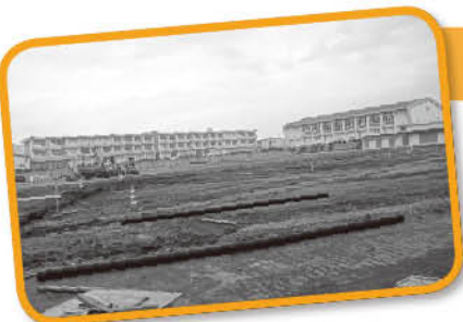
中学校運動場の改修工事
