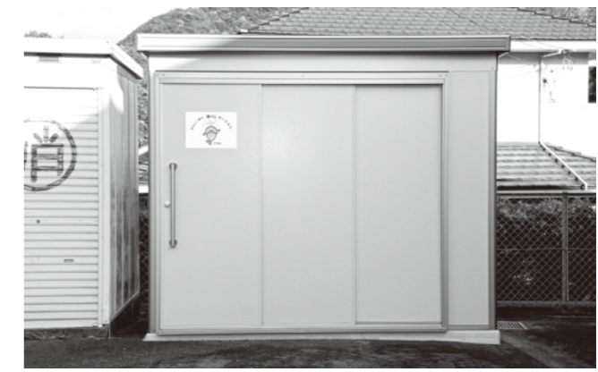
地震解錠装置付き防災倉庫 (鮎川自主防災会)
