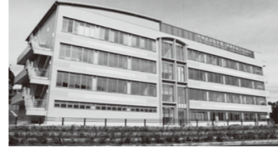
【建物概要】 鉄筋コンクリート造4階建て 免震構造(一部耐震) 延べ5960.01㎡
