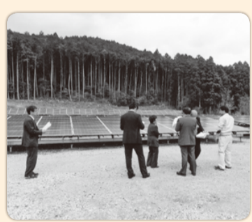
★柵橋地内(岸上、野垣外)太陽光発電設備
