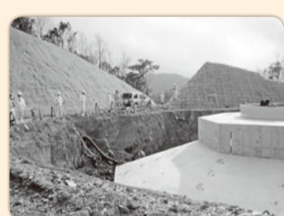
★風力発電建設現場確認
