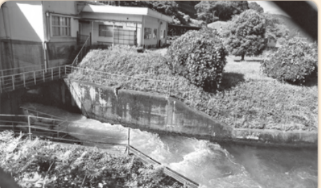
宮川第2発電所…昭和33年運転開始、最大使用水量24トン毎秒を三浦湾に直接放流している。
