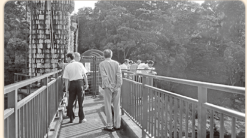
滝原堰堤…昭和29年完成、大内山川から取水、長ヶ発電所へ。
