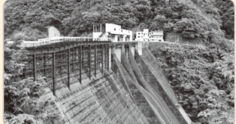
宮川ダム…昭和32年完成(築約59年)、維持放流：0.5トン毎秒、宮川第1・第2発電所へ24トン毎秒を放流…通常時、直下に、もはや川はない。
