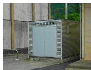
小川郷地区備蓄倉庫
