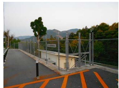
棚橋水源地 (機械室)
