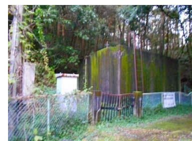
(旧) 棚橋配水池
