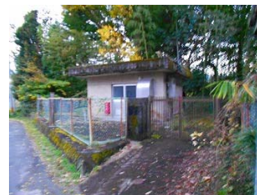
(旧) 棚橋浄水場
