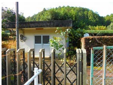
(旧) 立岡配水池
