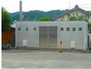
中川地区備蓄倉庫
