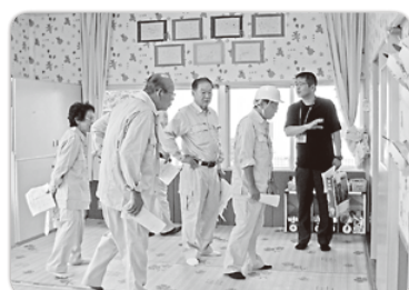
長原保育所改修工事
