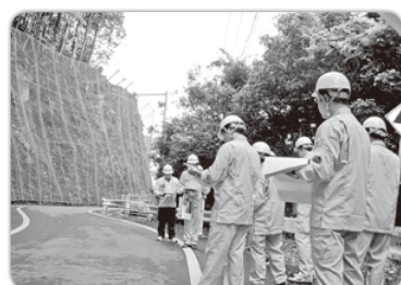
落石防護網設置工事
