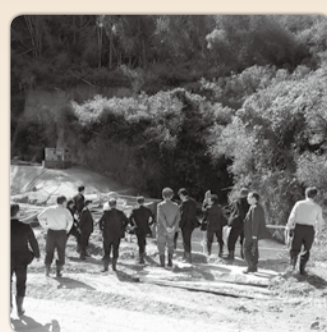
鹿屋大崎ソーラーヒルズ 発電所建設工事現場
