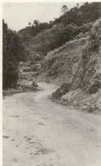
県道の改良工事も順調に進む……
