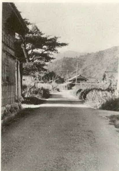
町道も拡幅・舗装へビッチ……
