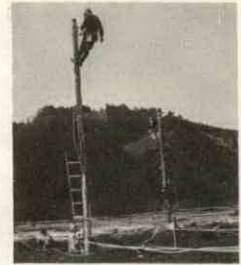
ファンの取付け工事
