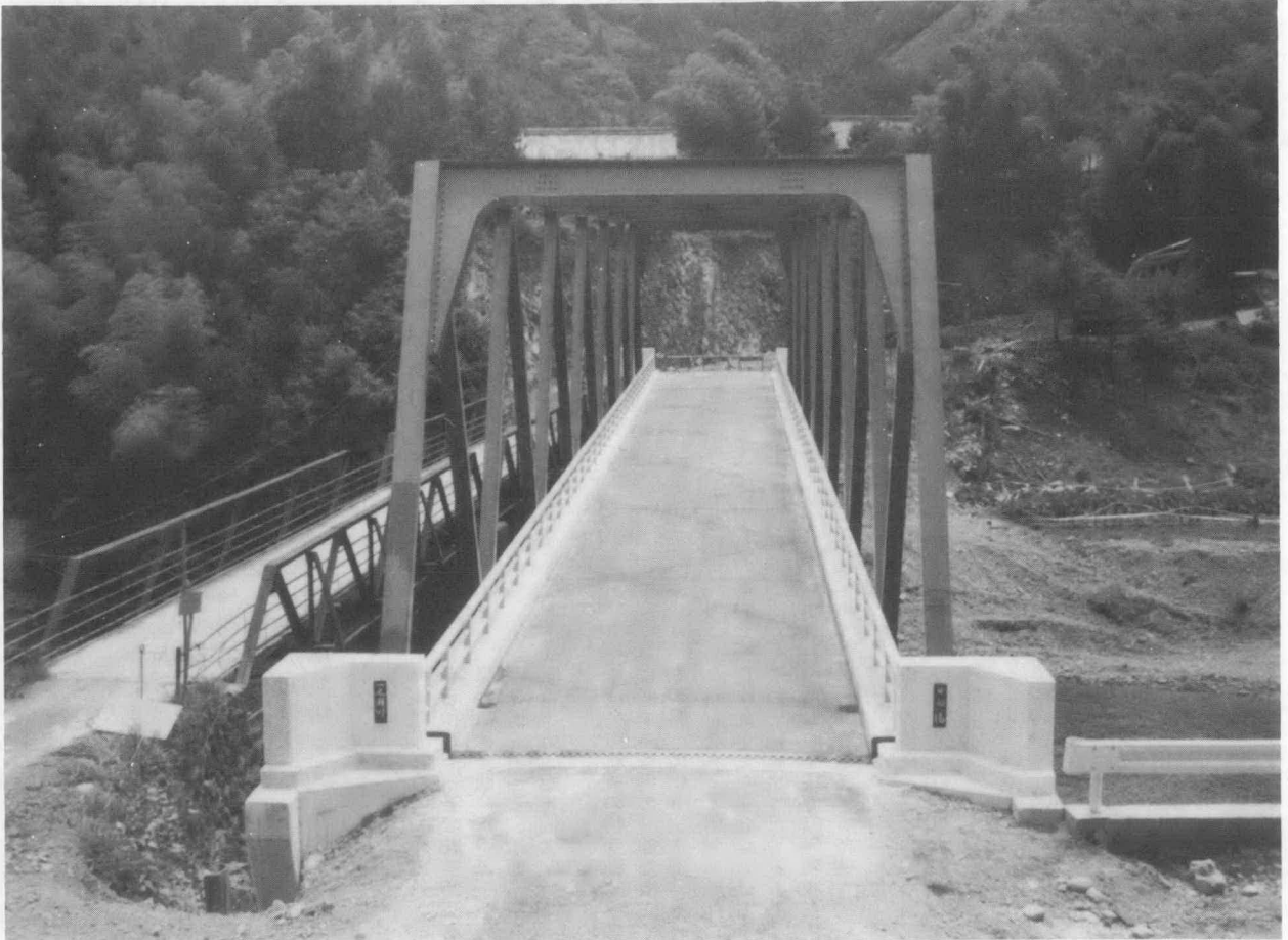
完成間近い日向大橋
