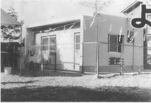
葛原配電盤室
