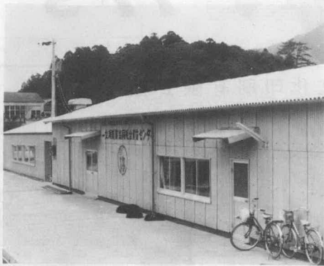
完成した育苗センター
