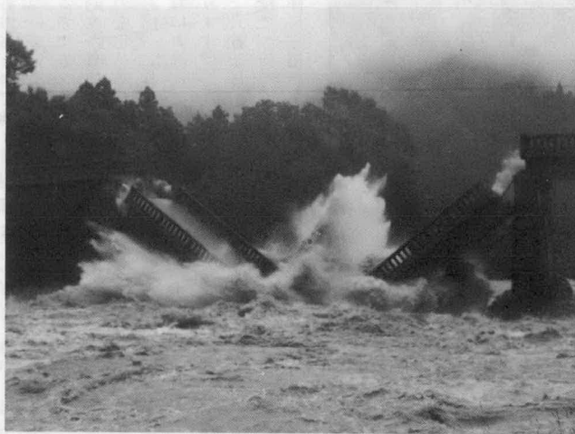
S 57年 8月3日 くずれ落ちた飛瀬浦橋—川口— (写真提供 堀之内正幸さん)
