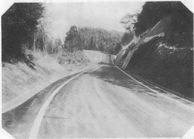
↑全線開通し、あと一・七キロの舗装工事を余すばかりとなった農免道路(上久具地内)
