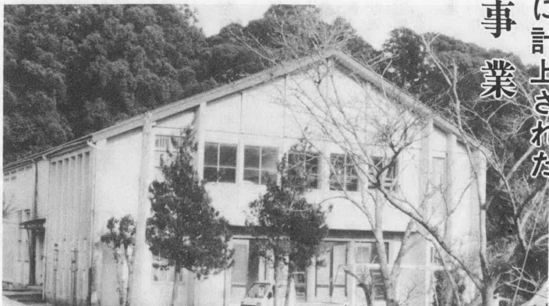
改築が計画されている一之瀬小の屋内運動場
