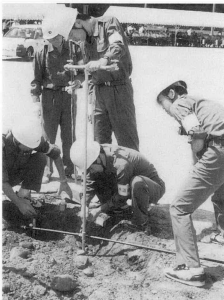
水道施設復旧
