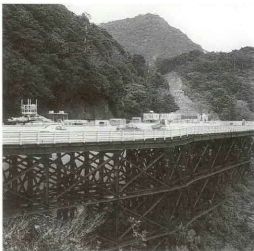
第2トンネル着工現場付近の仮設道路
