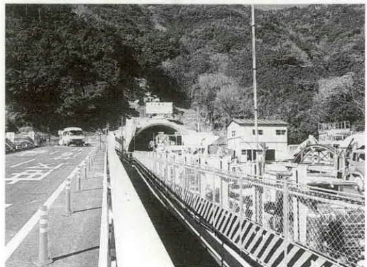
工事が始まったこう口付近
