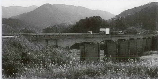
新橋梁を目指す 内城田大橋
