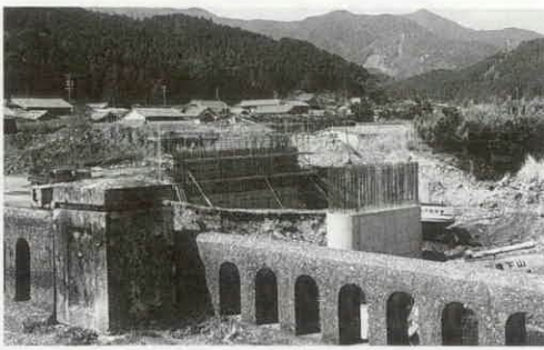
工事が進む梅橋
