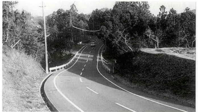
拡幅された麻加江・立花間
