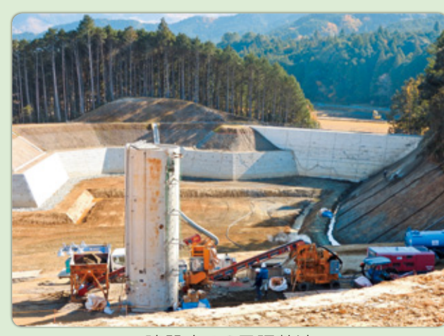
建設中の2号調整池
