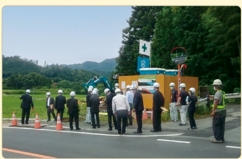
嵩上げ工事視察風景
