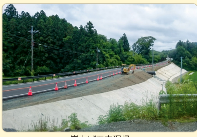
嵩上げ工事現場
