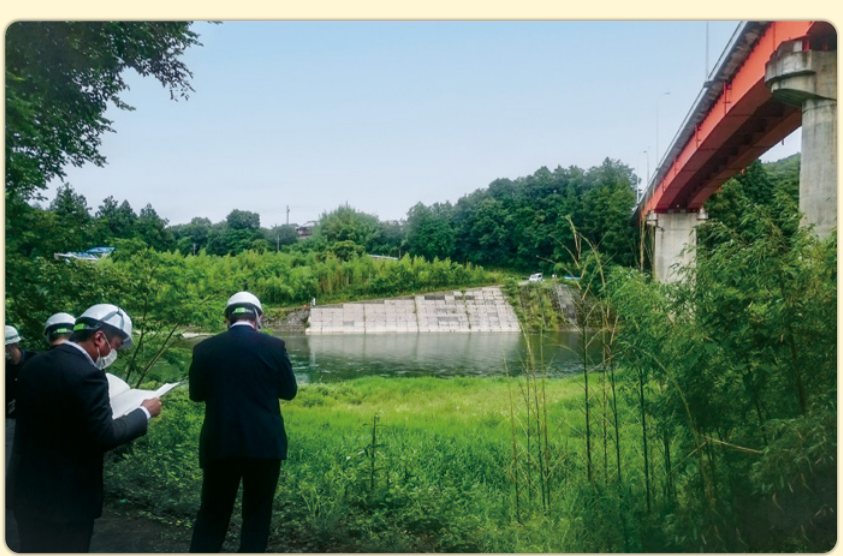
橋脚の状況視察風景
